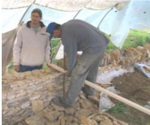
Damien enroule les cordons de maçon sur une pierre de support
