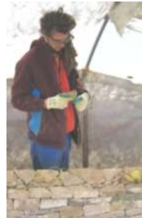
Damien enroule les cordons de maçon sur une pierre de support
